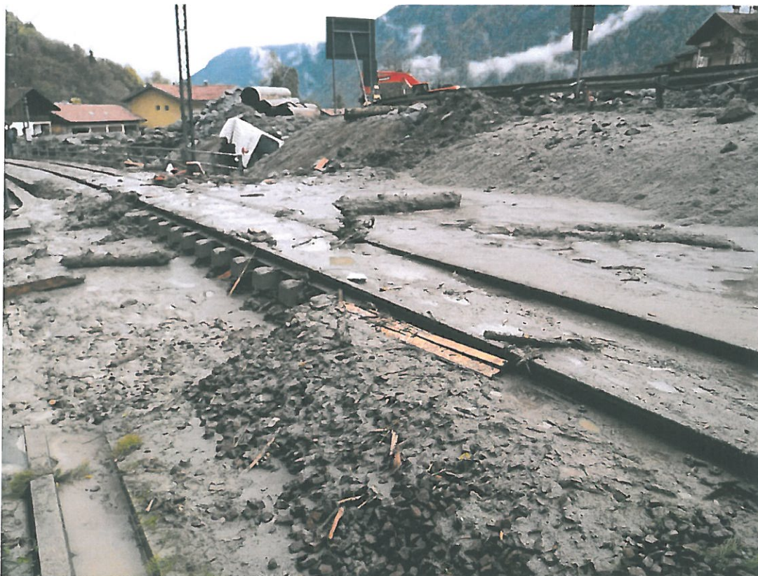
Foto 8. km 61+000 ca. in loc. Dimaro: colata detritica di enormi dimensioni con interessamento del paese di Dimaro, della S.S.42 e della linea ferroviaria
