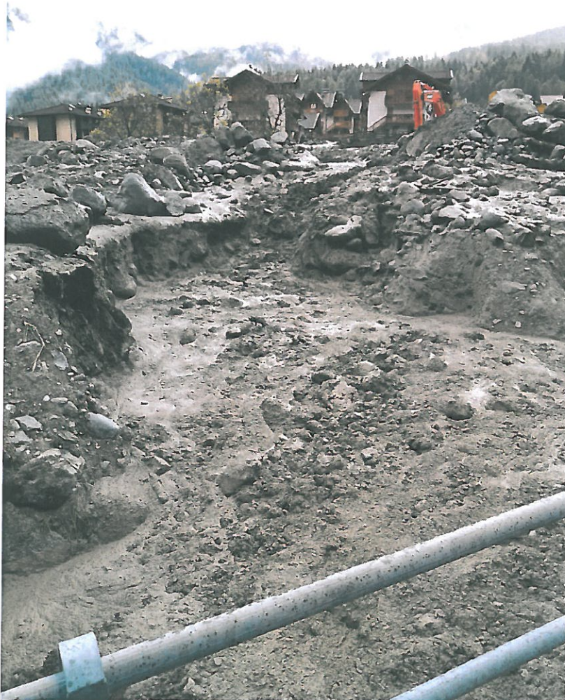
Foto 9. km 61+000 ca. in loc. Dimaro: colata detritica di enormi dimensioni con interessamento del paese di Dimaro, della S.S.42 e della linea ferroviaria
