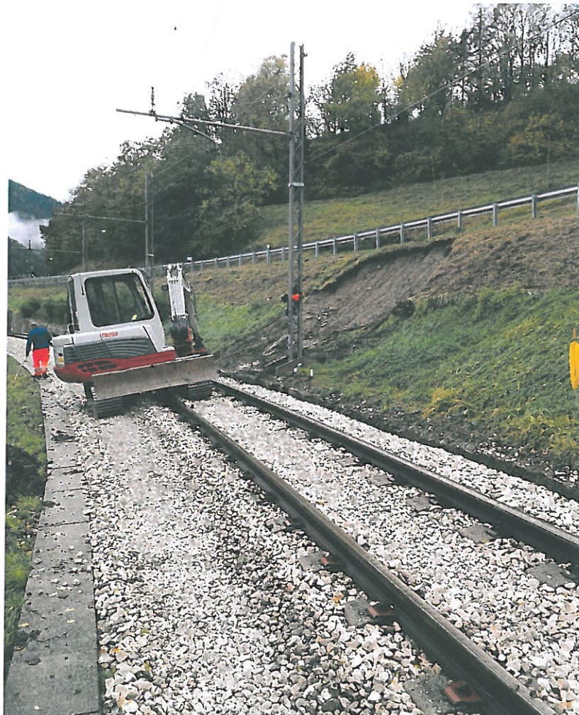
Foto 7. km 51+900 ca. in loc. Caldes: scivolamento della coltre superficiale del pendio ubicato in fregio alla linea
